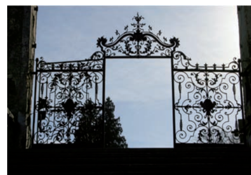
Żeliwna, zdobiona brama wejściowa do zamku (fot. Marek Gaworski)
