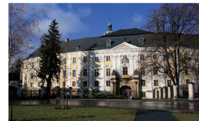
Główna fasada bruntalskiej rezydencji wraz z wjazdem na dziedziniec. Stan z 2008 roku (fot. Marek Gaworski)
