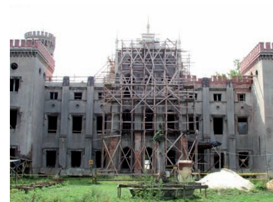
Na zdjęciu stan z 2008 roku, w czasie trwania prac remontowych (fot. Marek Gaworski)
