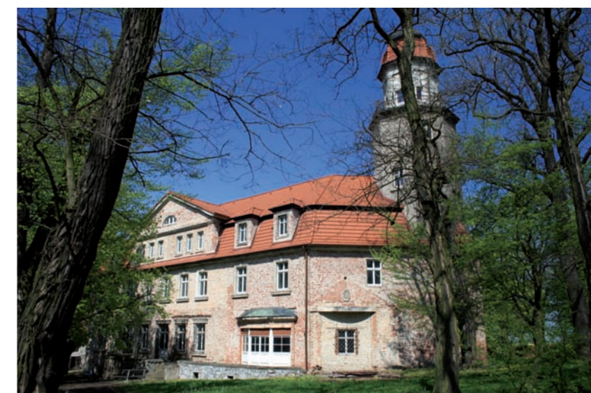
Pałac wiosną 2009 roku w trakcie prac remontowych (fot. Marek Gaworski)
