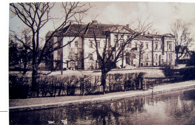
Główna część pałacu od strony południowej. Obecny wygląd budowli jest efektem przebudowy przez rodzinę von Pfeil
